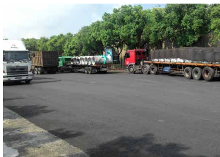
試鋪道路耐重車滾壓
