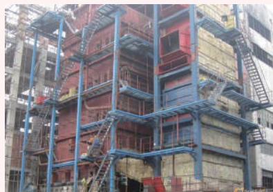
興建中電站鍋爐
